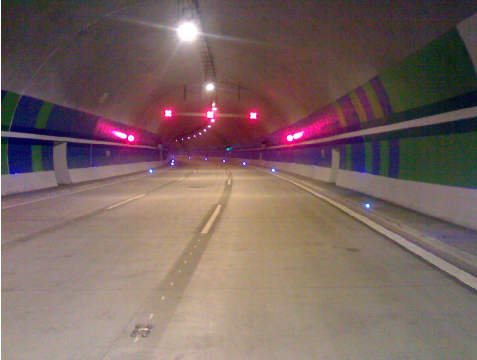
Obrázek 10 - Použití vodících trvale svítících knoflíků v tunelu
